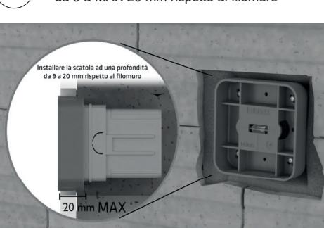
10a Posizionare con le 4 viti agli angoli il telaio EKINEX E71
